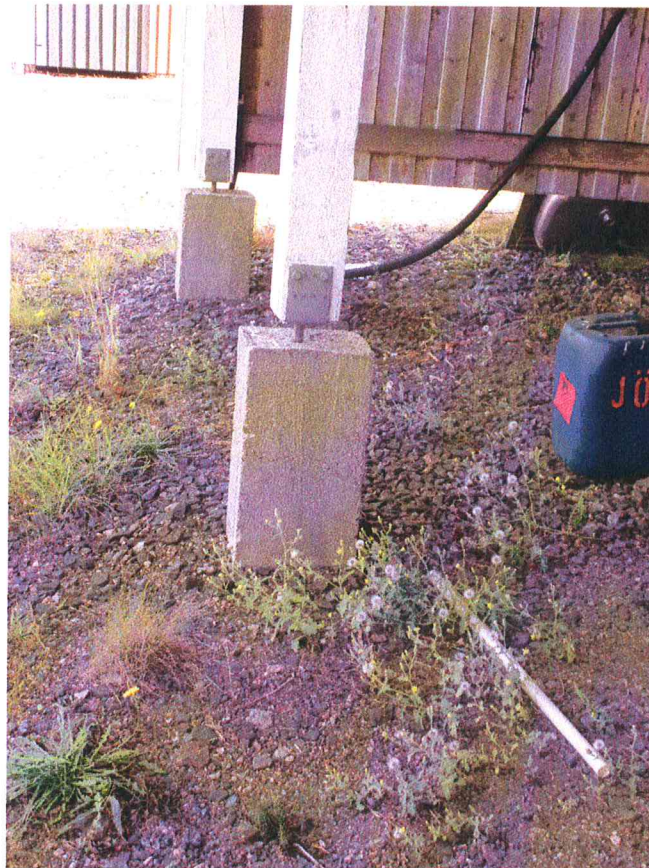
Valokuva 2. Perustukset ja rakennuksen runko.
